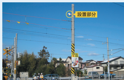
踏切設置(全景)
