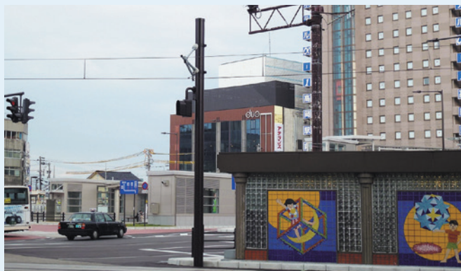
信号機付電車線柱
