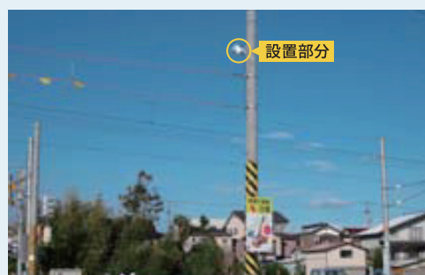
踏切設置(全景)
